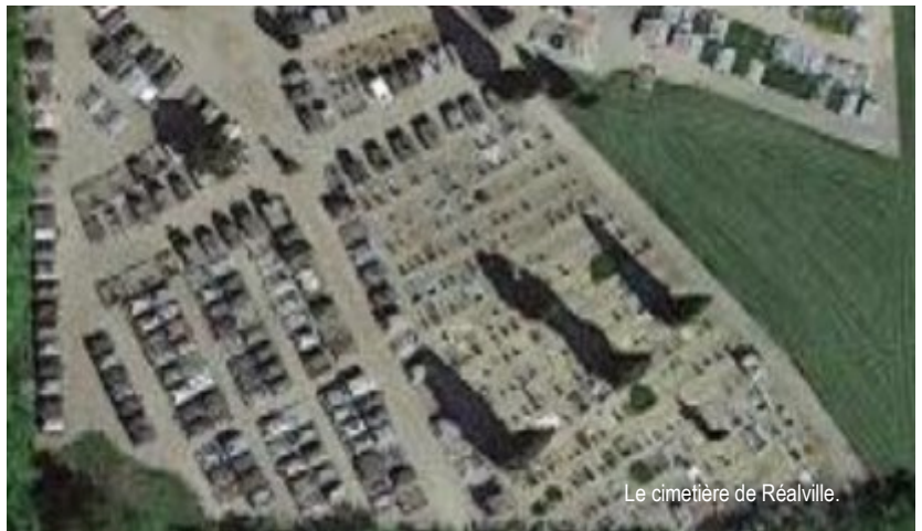
Engazonnement en cours
